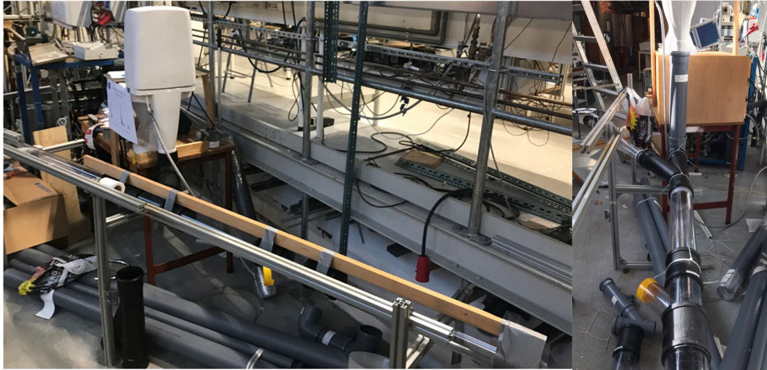
Figur 3: Experimentell uppställning för tester av återspolning i duschspillvattenledning.
